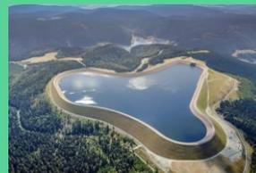
**con impianto di accumulazione**, simili alle centrali a bacino, ma permettono di accumulare l'energia per le ore di maggior richiesta. Possono essere costruite anche in piccola scala e permettono una vasta fornitura di energia
