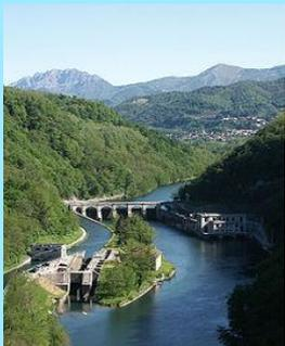
**ad acqua fluente**, che sfruttano la portata naturale del fiume e attraverso questo viene spinta contro le turbine che ruotando trasformando il moto in energia elettrica.
